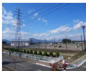
工事現場の様子
